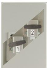
Verschiedene CO<sub>2</sub>-Fernauslöseboxen mit elektrischen oder mechanischen Auslösegeräten
